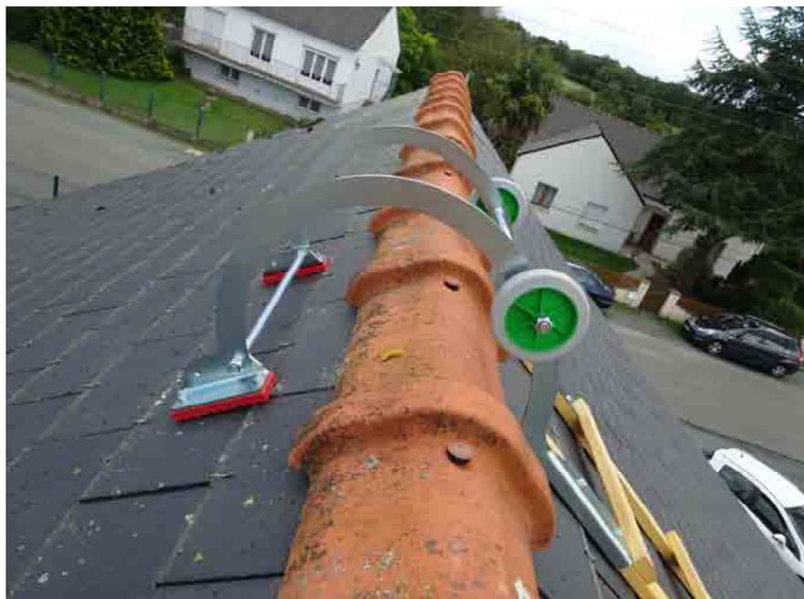
**Crochets destinés à retenir l'échelle sur le faîtage de la toiture.**
